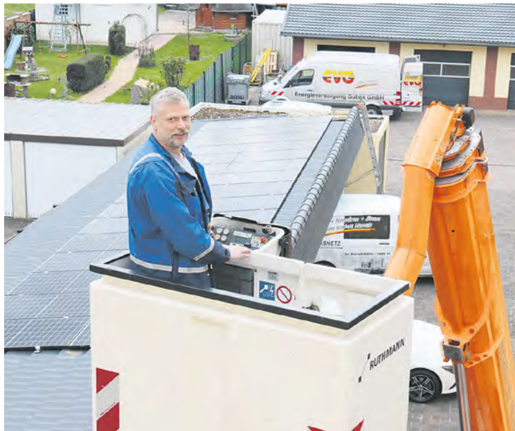
EVG-Mitarbeiter sind immer auf der Höhe der Zeit – so wie hier Toni Krüger am Solar-Carport. Foto: SPREE-PR/ml
