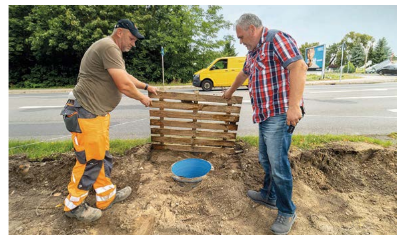
Bodo Nozinsky (l.) von der bauausführenden Firma ULT e. G. aus Guben und Matthias Krause von der SWG besprechen den Neubau des Geh- und Radweges in der Cottbuser Straße. Fotos (2): SPREE-PR/Petsch
