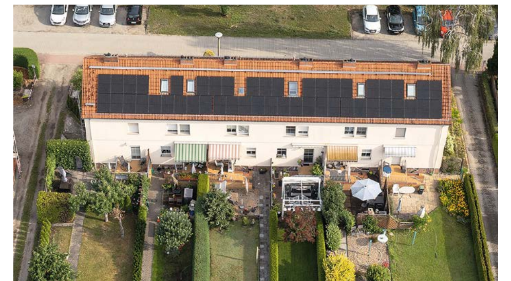
In unmittelbarer Nachbarschaft wurden die Solarmodule bereits auf dem Wohngebäude der Gubener Wohnungsbaugenossenschaft eG installiert.
