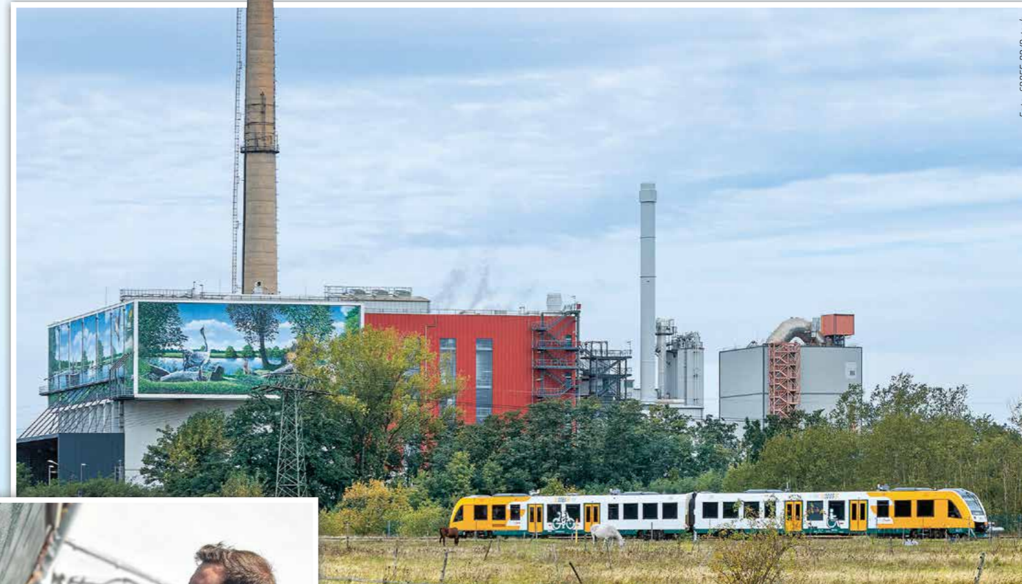
Industriemalerei am EEW-Kraftwerk in Premnitz (Havelland). Der „Havelspaziergang“ ist Brandenburgs größtes Gemälde und gleich prominent sichtbar, wenn man die Stadt mit Auto oder Bahn erreicht.
