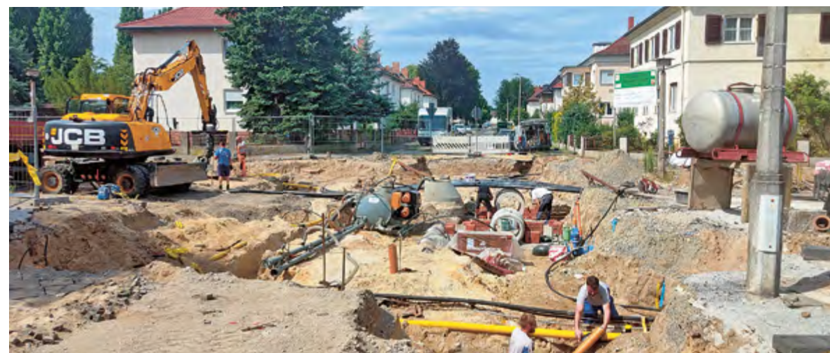
Bei dem Großprojekt in der Gubener Friedrich-Engels-Straße arbeitete ULT eng mit anderen regionalen Firmen zusammen, darunter mit der EVG. Im Vordergrund des Bildes ist die Umverlegungen der Gasleitungen zu sehen. Foto: ULT
