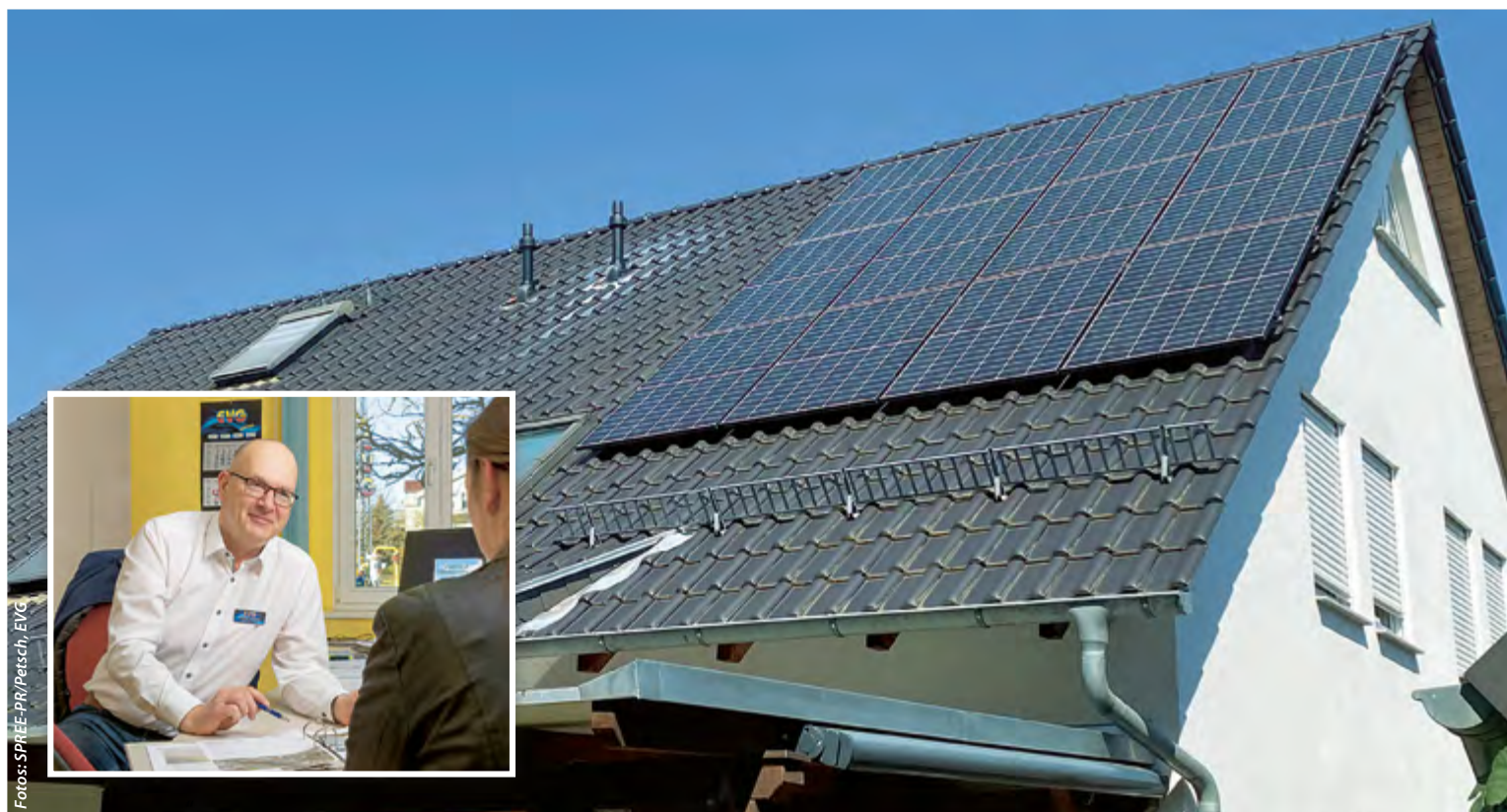
EVG-Mitarbeiter Thomas Dressler berät individuell und passgenau zu PV-Anlagen und Balkonkraftwerken. Im Bild die PV-Anlage auf dem Eigenheim der Familie Stops. Hier blieb das Licht an, als wegen eines Kabelschadens bei Bauarbeiten in der Nähe andere Haushalte ohne Strom waren.
