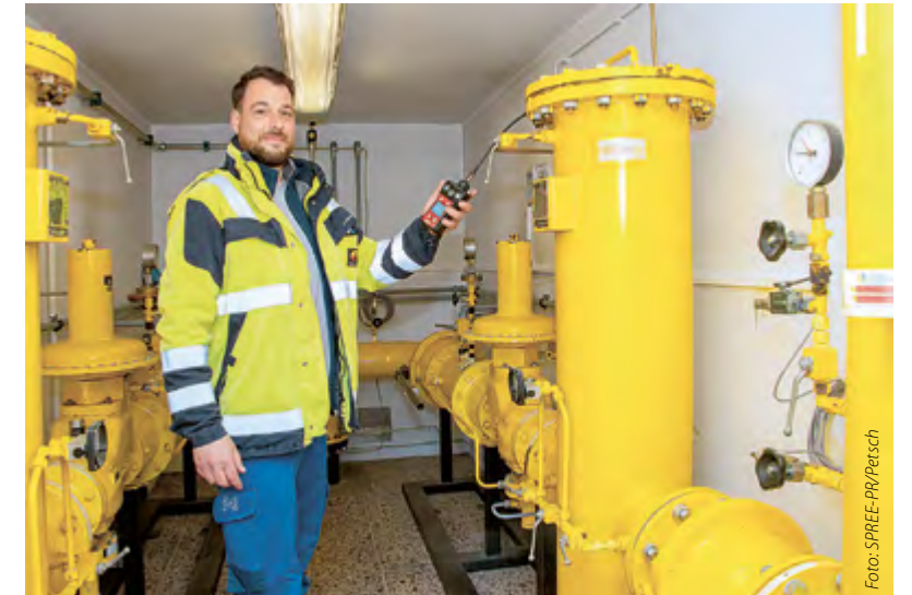
Mitarbeiter Kurt Rausendorff von der EVG in der Gasdruckregelanlage in der August-Bebel-Straße. Die GDRA sorgt dafür, dass der Gasdruck auf 22 hPa gesenkt wird, um Haushalte im Niederdruck mit Erdgas zu versorgen. Foto: SPREE-PR/Petsch
