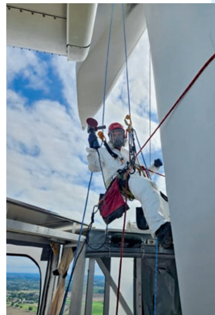
Bei Windrädern ab 100 Metern Höhe kommen mobile Arbeitsbühnen zum Einsatz. Alle Arbeitsgeräte, wie der Schleifer, sind an Seilen gesichert.
