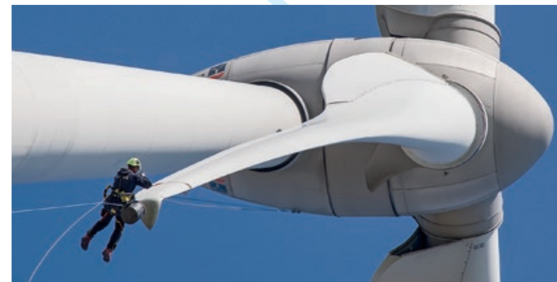
Aus der Frosperspektive: Ein Rotorblatt wird auf Abrieb kontrolliert. Der „Nack“ in der Rotorblattspitze ist ein sogenanntes Winglet und dient zum kontrollierten Strömungsabriss.
