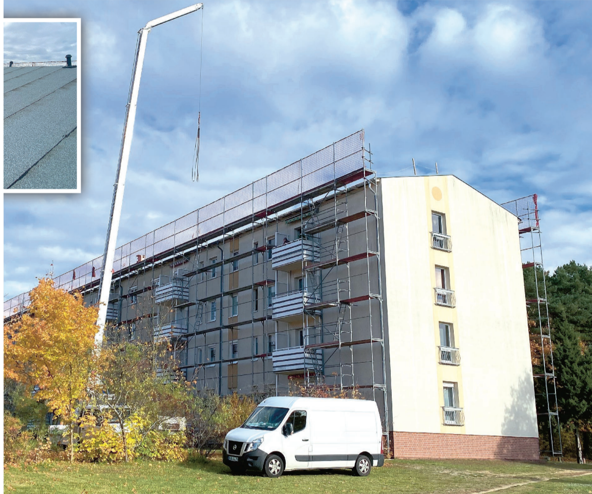
Das Haus in der Goethestraße eingerüstet und das Dach für die Montage der Photovoltaik-Anlagen vorbereitet. Die Bewohner künftig vom Mieterstrom-Projekt der EVG.
