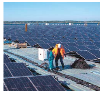
Rohrleitungen werden unter dem Seeboden für die Verkabelung vorbereitet. Foto: LEAG/Norman Göbeler
