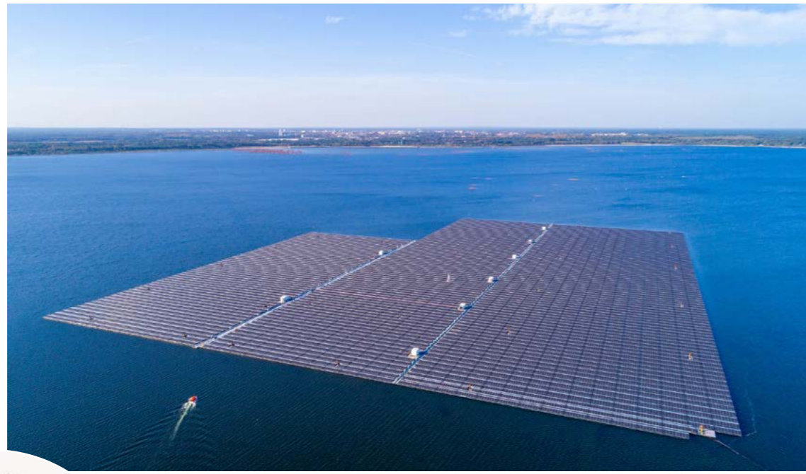
Deutschlands größte Floating-PV-Anlage auf dem Cottbuser Ostsee soll in der 1. Jahreshälfte ans Netz gehen. Im Foto sieht man die finale Kontur, alle Solarmodule sind montiert. Foto: LEAG/Andreas Franke
