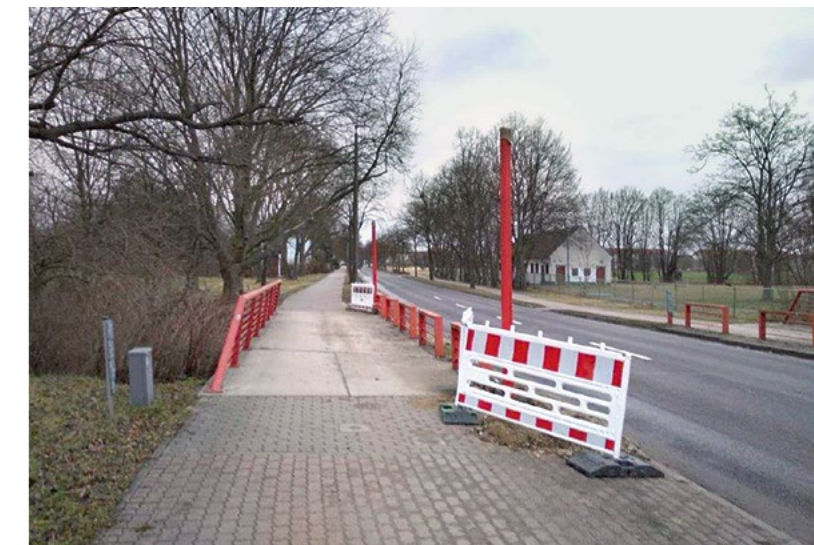
Vier neue LED-Straßenlampen wurden in der Sprucker-Straße aufgestellt. Foto: SWG
