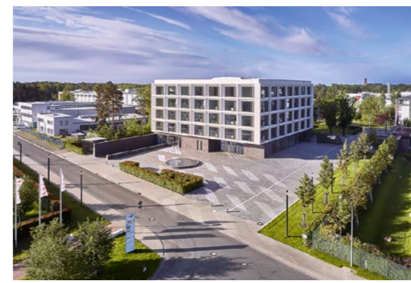
Der Stammsitz von ORAFOL: Über 200 Produktionsanlagen befinden sich in Oranienburg, weitere werden gebaut.
