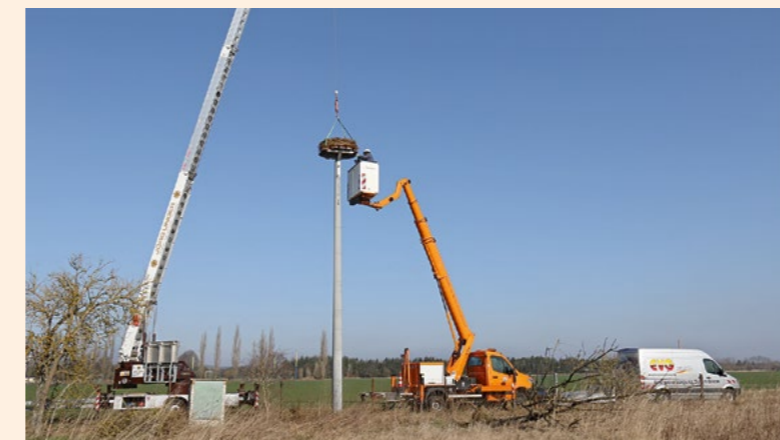
Ein Kran der Firma Unger hebt das Nest auf den Unterbau, wo es sachgerecht befestigt wird.
