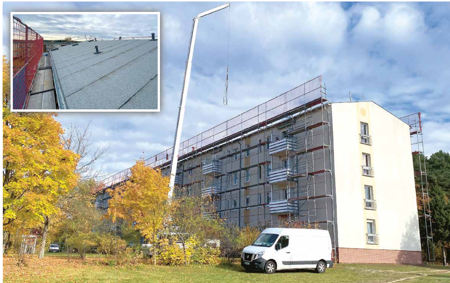
Anfang November wurde das Wohnhaus in der Goethestraße eingerüstet und das Dach für die Montage der Photovoltaik-Anlagen vorbereitet. Hier profitieren die Bewohnerinnen und Bewohner künftig vom Mieterstrom-Projekt der EVG.
